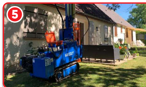
5 Investigations géotechniques avant travaux
