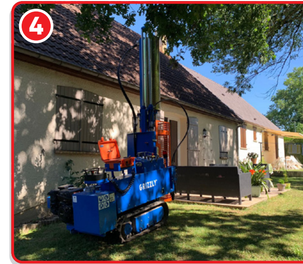
4 Étude de sol géotechnique et diagnostic des réseaux avant travaux
